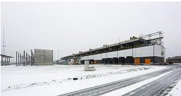
4. Kiisa avarielektrijaam - Kiisa, Saku vald, Harjumaa;
