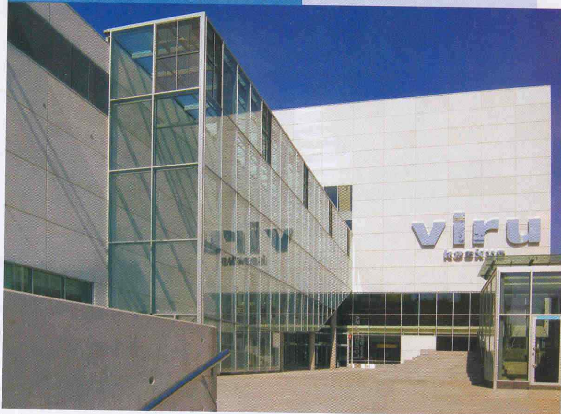
Viru keskuse kaunites valgetes betoonpaneelides kasutas E-Betoonelement eranditult roostevabast terasest sarrust.
