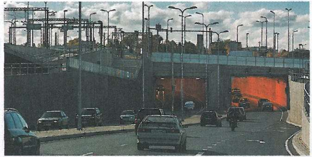
ÜLEMISTE liiklussõlm Tallinnas. FOTO: EESTI BETOONIÜHING
