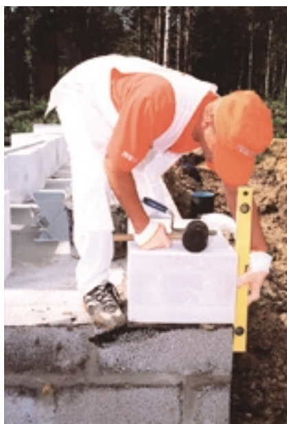
AEROC-plokkide loodimiseks on vaja lihtsaid vahendeid – vaaderpassi ja kummivasarat.
