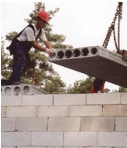
Raudbetoonist õõnespaneelide paigutamine kandvale AEROC-välisseinale.
