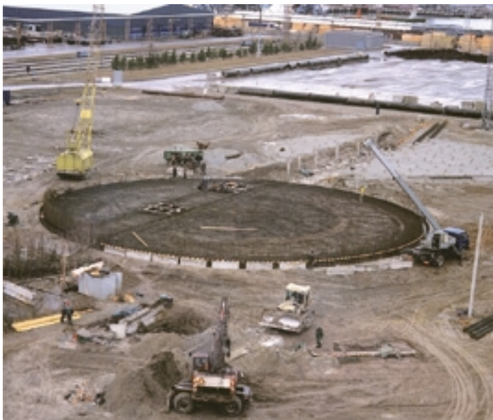
Vundament eeldab piisava kandevõimega aluspinda. Kuppelladude põrandad on unikaalsed. 40 cm paksuse plaadi koormuseks on arvestatud 20 t/m 2 .
