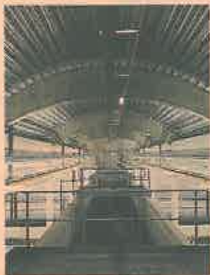
TALLINNA reoveepuhastusjaama biofiltri hoone
