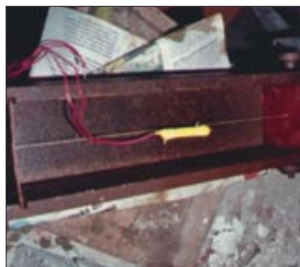
Sisedeformatsiooni anduri T-20 paigaldamine vormi.
