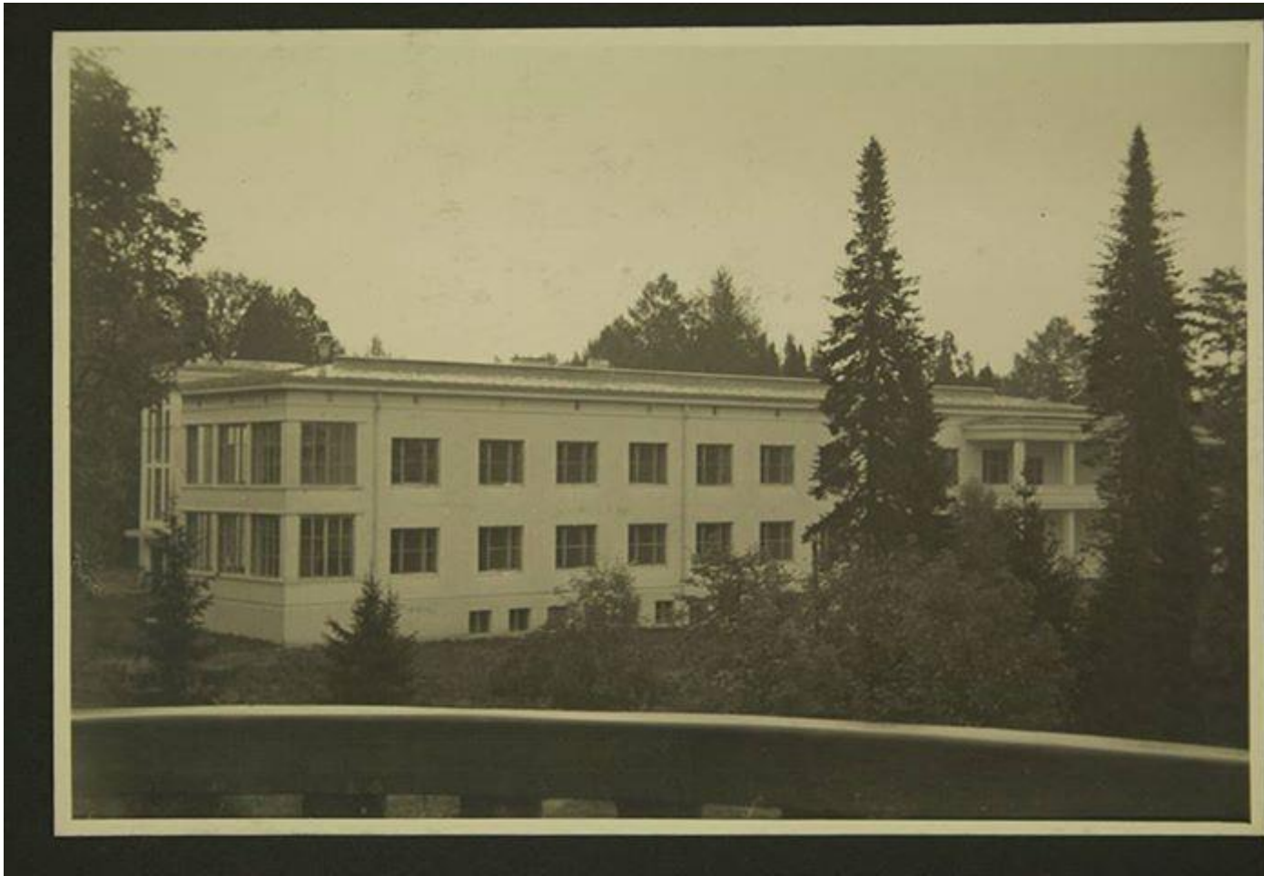
Taagepera tuberkuloosisanatoorium, arhitektid Alar Kotli, Johannes Fuks, konstruktor Ado Johanson, 1938-1942, valminud 1947. Foto 1948. Eesti Ajaloomuseum AM F 5816:41
