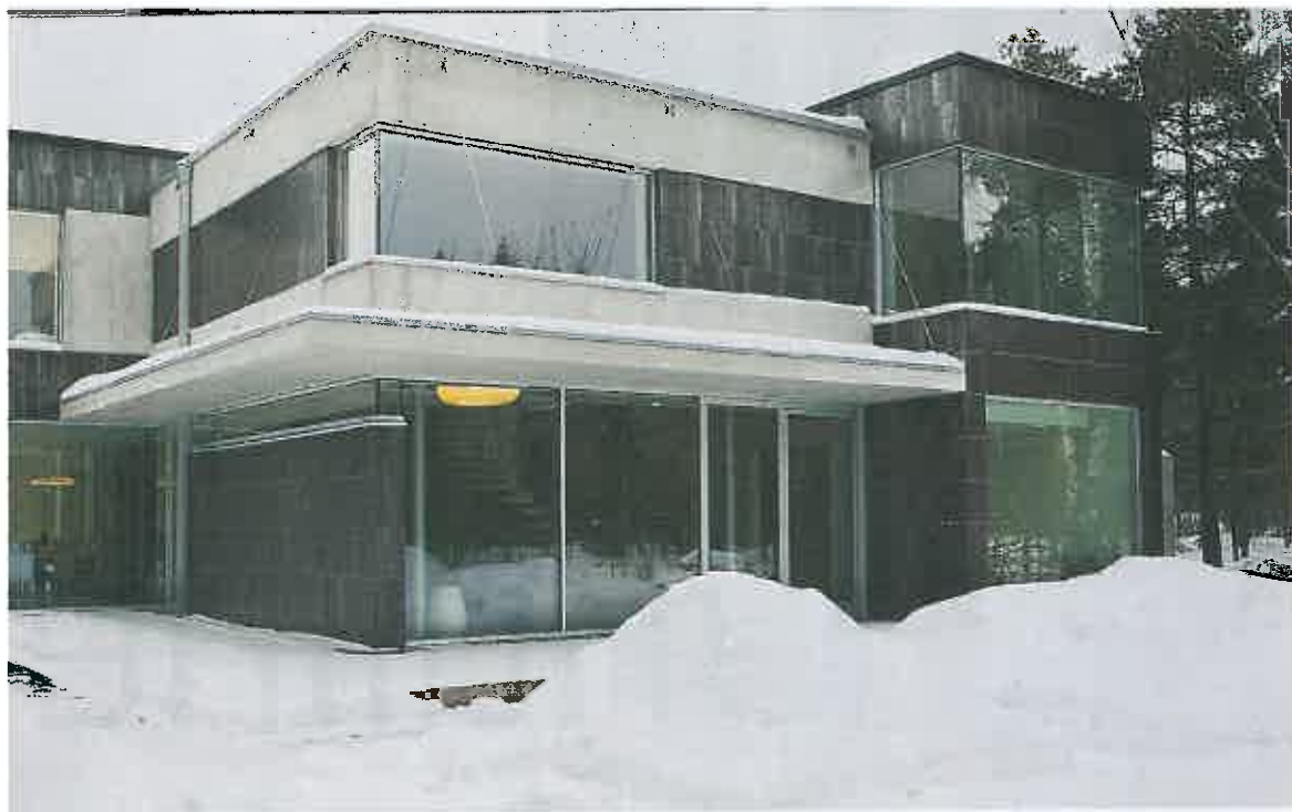
Hoone fassaadis domineerivad klaas, betoon ja keraamilised plaadid.
