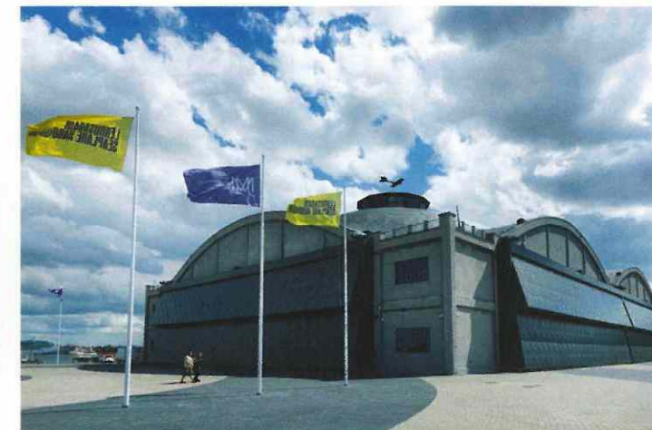
VESILENNUKITE ANGAAR polnud 95 aastat remonti näinud. Koorikkuplite taastamine oli seega suur ehitusalane proovikivi.
